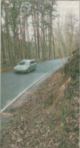
Montagrufur hat die Abbruchstelle geräumt. Foto: M. Lücke
